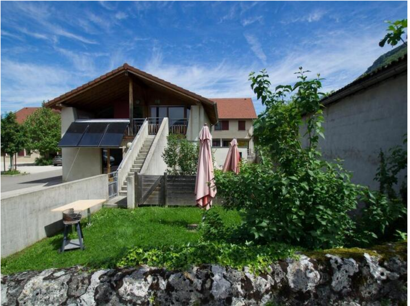
Les Gîtes communaux de La Rivière 38210 La Rivière
