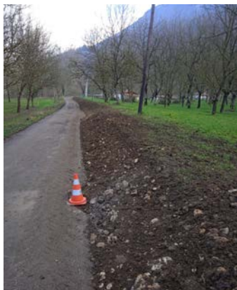
Travaux d'enfouissement de la ligne électrique chemin des Brunières
